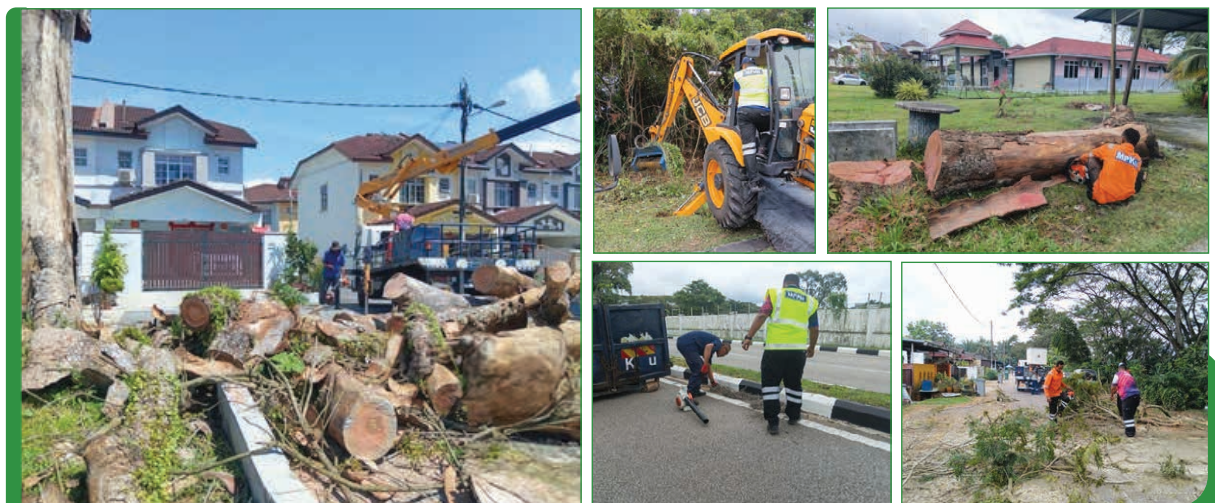
Kerja-kerja penyelenggaraan pokok tebang dan cantas secara in-house.
