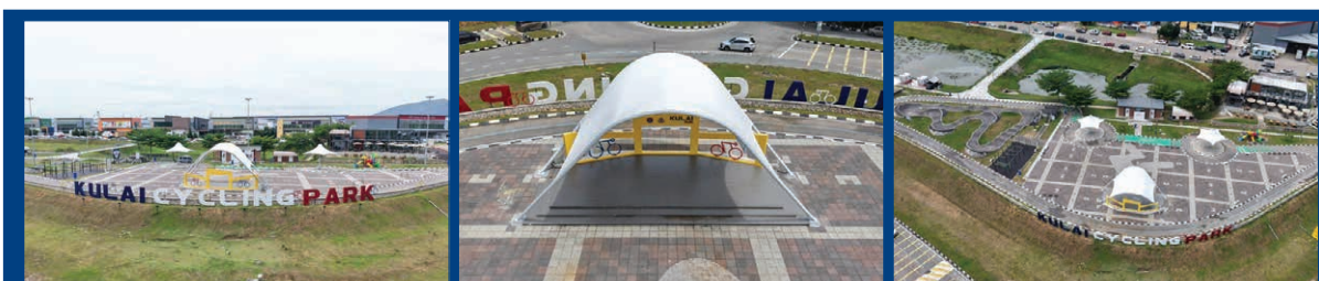
Membina Struktur Bumbung Dan Parkir Kenderaan Dan Trek Tambahan Di Kulai Cycling Park, Indahpura, MP Kulai.
