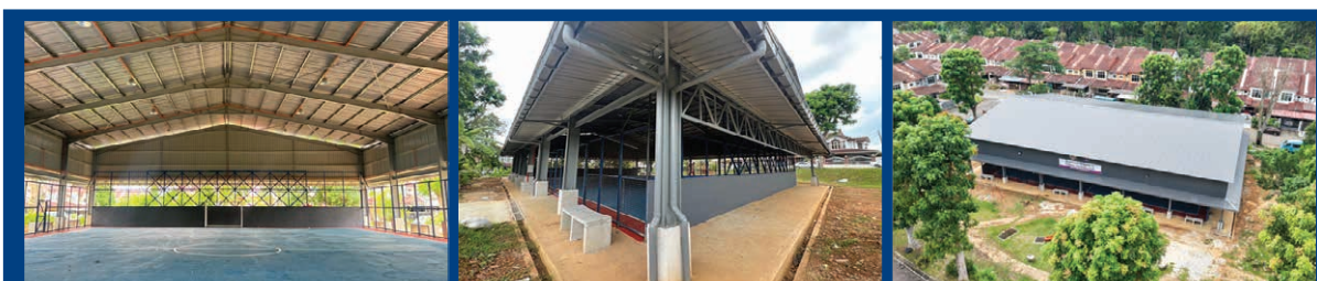
Kerja-Kerja Membina Struktur Bumbung Serta Kerja-Kerja Berkaitan Di Gelanggang Futsal Kejuruan Cempaka, Indahpura, Kulai.
