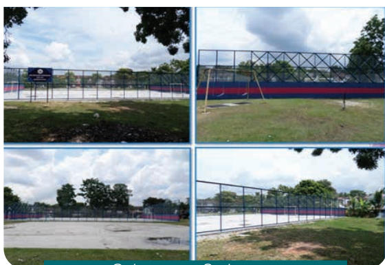
Gelanggang Serbaguna Jalan Melati, Indahpura
