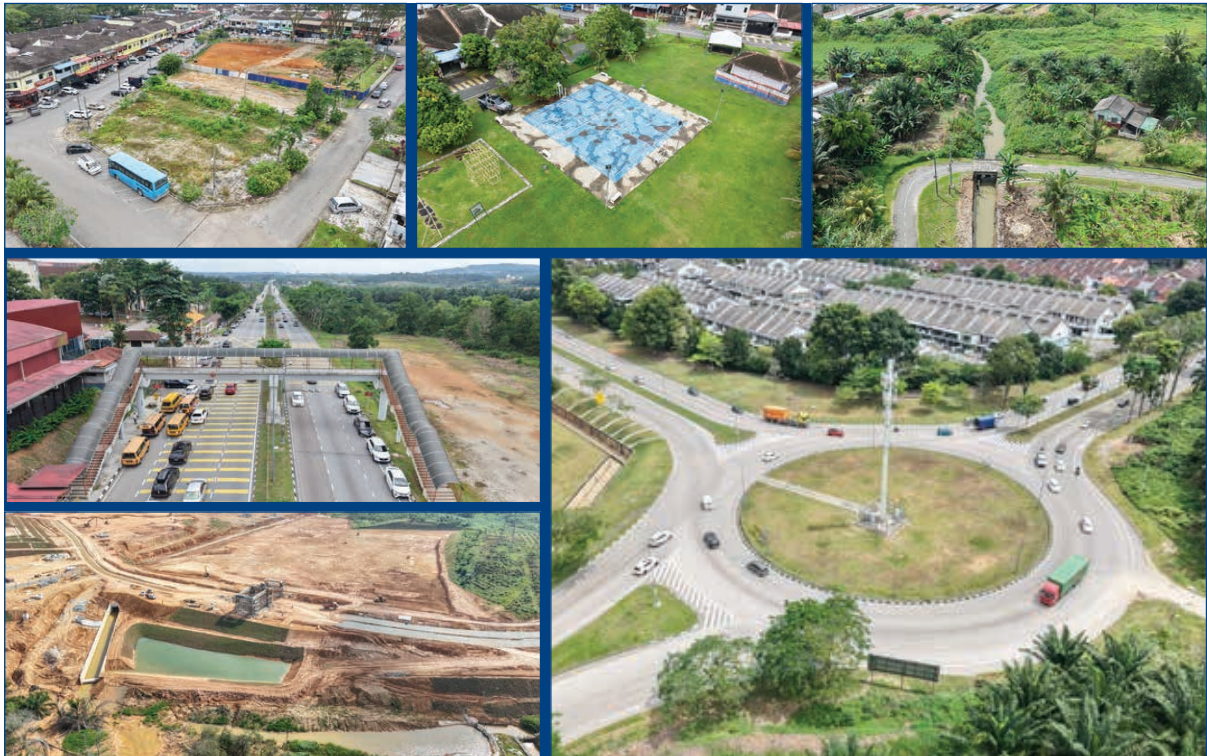
Gambar yang menunjukkan pelaksanaan siasatan awal bagi projek pembangunan Majlis Perbandaran Kulai (MPKu) dan kerja-kerja infrastruktur berkaitan.
