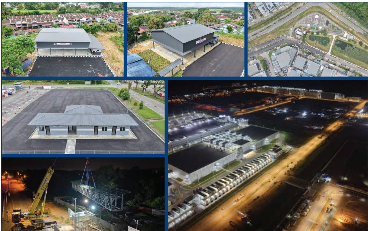
Gambar dron bagi kerja-kerja yang telah siap dibina dari sudut (angle) yang sukar dicapai, termasuk pemantauan lampu jalan serta pemantauan proses pemasangan struktur jejantas pada waktu malam.
